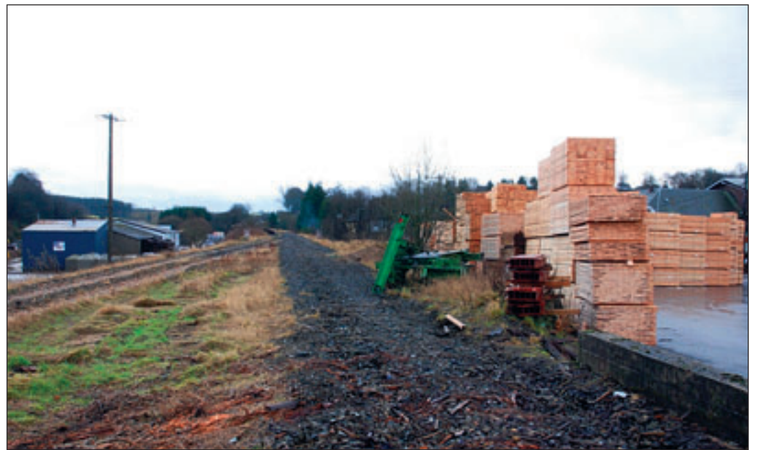
Mehrheit und Opposition im Büllinger Gemeinderat sind sich darüber einig, dass die ehemalige Bahnlinie Weywertz-Jünkerath (hier im Bereich des Sägewerks Pauls) sowohl als Trasse für einen Radwanderweg als auch für eine Umgehungsstraße in Frage kommt.
