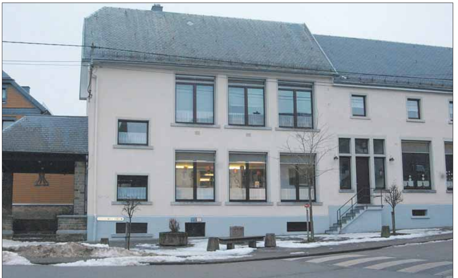
Der Schule in Wirtzfeld (Foto) werden von der Gemeinde Büllingen rund 22 Festmeter Holz zur Verfügung gestellt. Das Material soll für den Bau eines Holunderspielplatzes verwendet werden.
