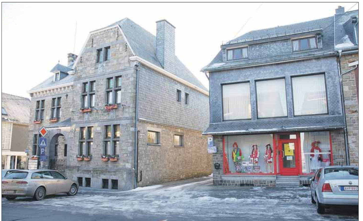
Für den Umbau des ehemaligen Hauses Weber gleich neben dem Gemeindehaus in ein Verwaltungsgebäude sieht die Gemeinde Büllingen 460 000 Euro im kommunalen Haushalt 2009 vor.
